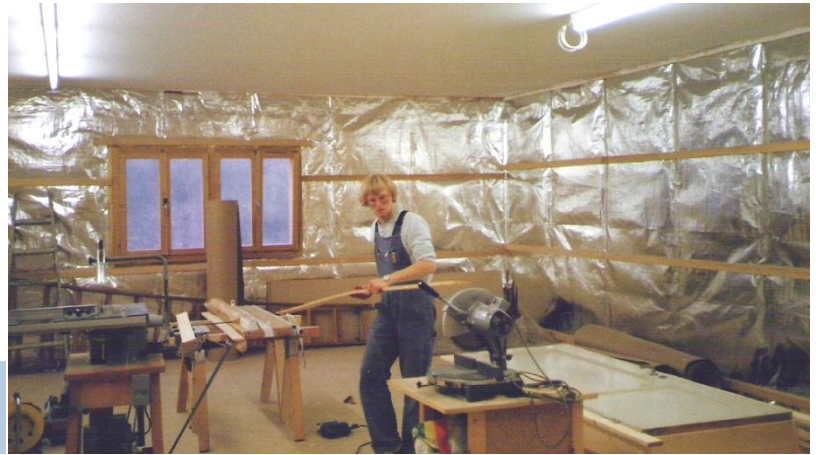
Mario Bachmann beim Innen- ausbau
